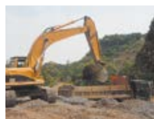
原石運搬 ブルドーザとパワーショベルで掘削した原石は、ダンプトラックでプラントまで運搬します。
