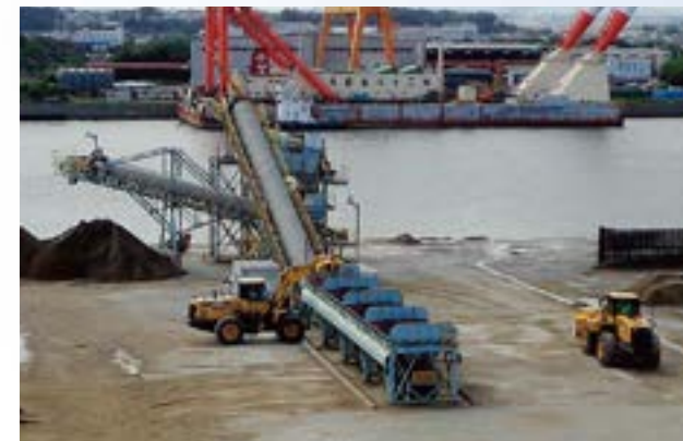
⑪ 奈良輪骨材センター
