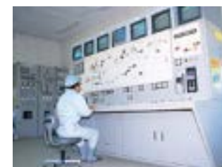
集中操作室 プラントの稼働状況が一目で分かる集中管理室で操作します。
