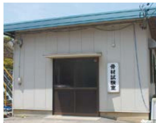
骨材試験室 各プラントに骨材試験室を設置し製品の品質を管理しています。
