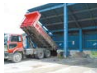
原石ホッパー投入 採掘した原石をプラントに投入します。
